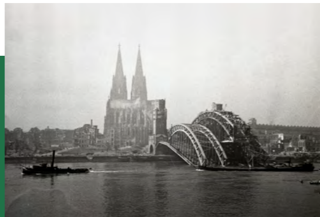
Die zerstörte Hohenzollernbrücke in Köln 1945
